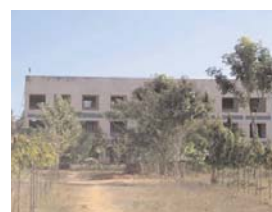
Bâtiment qui sera réhabilité pour l'école de formation à Pondichéry
