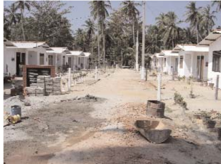
Construction de maisons à Palangathure au Sri Lanka
